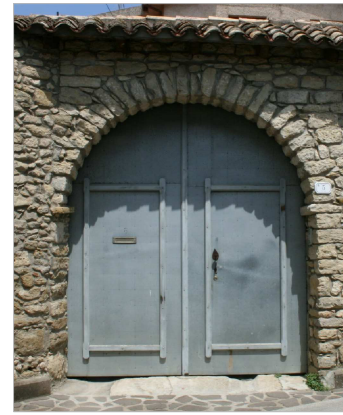
INFISSO IN LEGNO E LAMIERA DI FERRO
