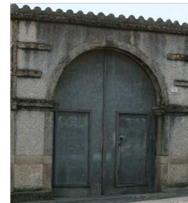
INFISSO IN LEGNO E LAMIERA DI FERRO
